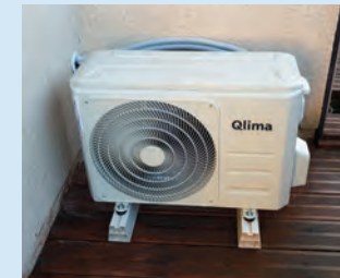
pose sur support PVC
